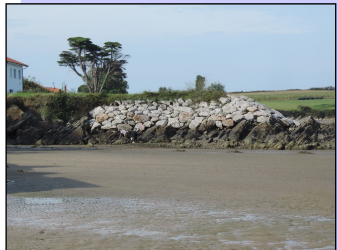
L'aición de la mar y la erosión punxo en peligru'l xacimientu medieval de Traslailesia. El movimientu vecinal forció la construcción d'una escollera col envís de guarecer el xacimientu.
